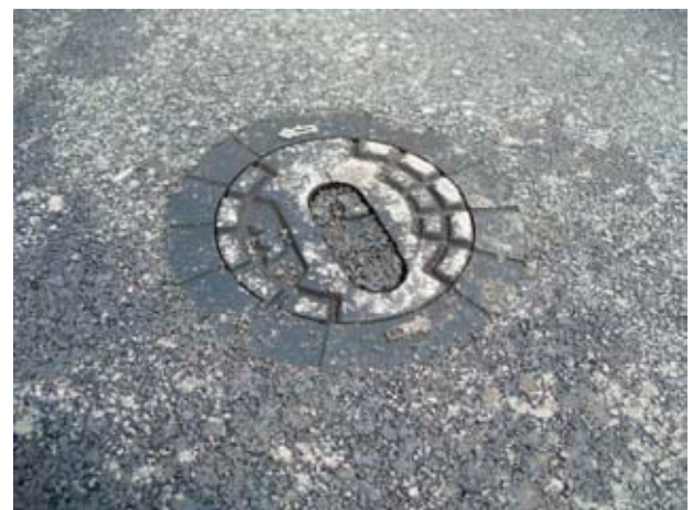
So sitzen Straßenkappe und die Oberfläche des Kopfloches millimetergenau.
