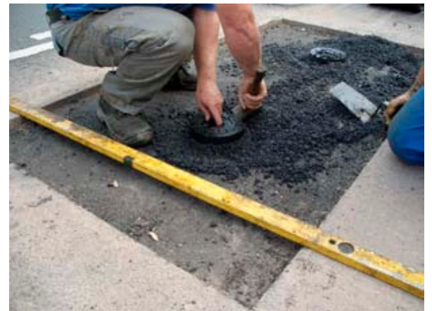
Kopfloch mit Asphalt auffüllen, Oberteil gut mit Asphalt unterstopfen.
