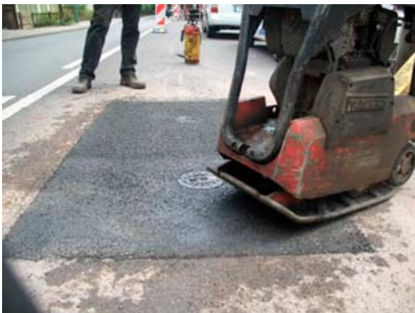
Oberteil in den Asphalt Einrütteln. Das gesamte Kopfloch gut verdichten!
