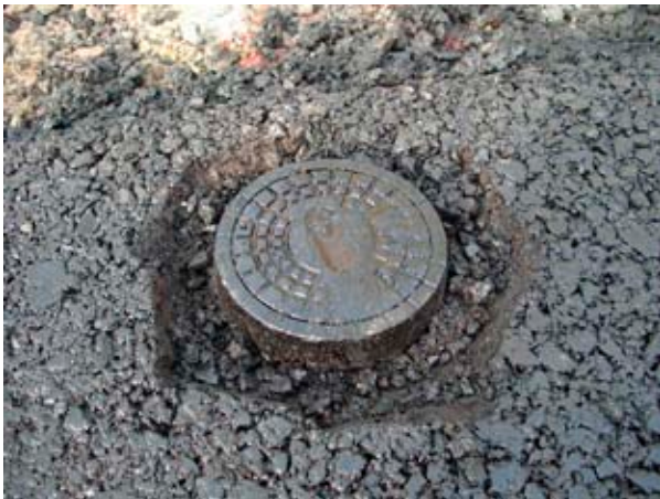
Unmittelbar nach dem Einrütteln in die Tragschicht – Oberteil frei machen!
