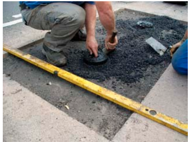
Kopfloch mit Tragschicht auffüllen, Oberteil gut mit Tragschicht unterstopfen, danach Oberteil fest Einrütteln.
